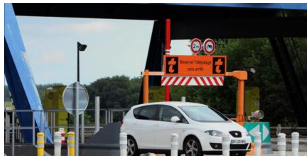
Le péage de Loupershouse a connu un lifting en 2000. Les travaux vont se poursuivre jusqu'en 2015. Photo Thierry NICOLAS
