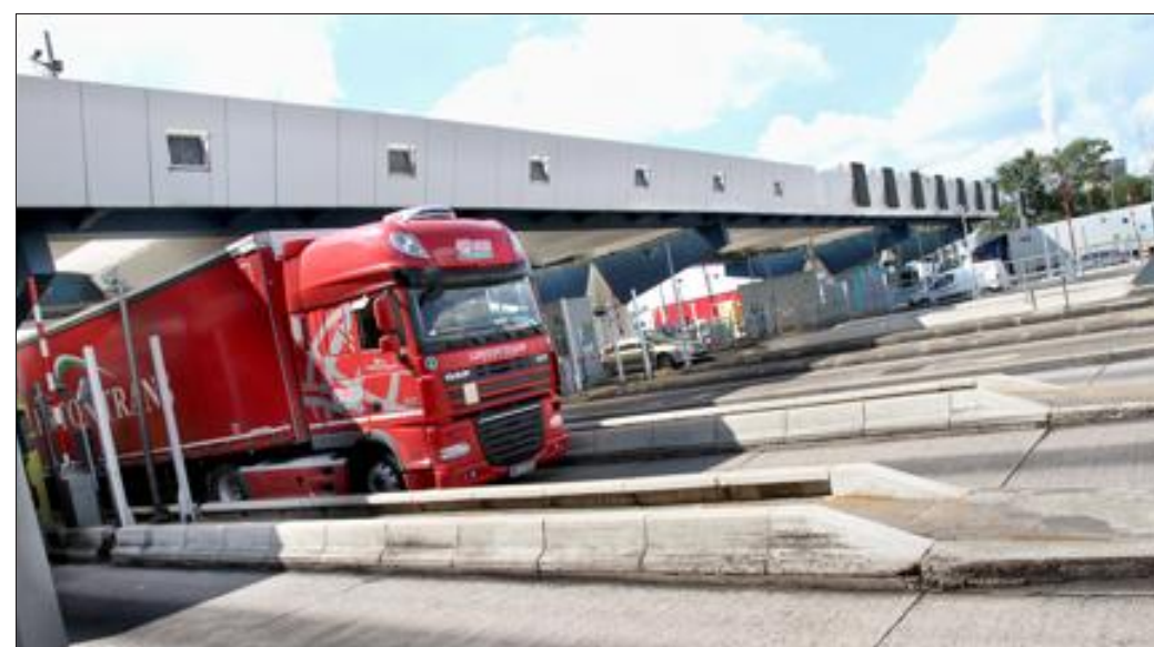
Le péage de Saint-Avold, comme les autres barrières de l'A4, sera réaménagé pour permettre aux camions d'utiliser les voies de télépéage sans avoir besoin de s'arrêter. Photo Thierry SANCHIS
