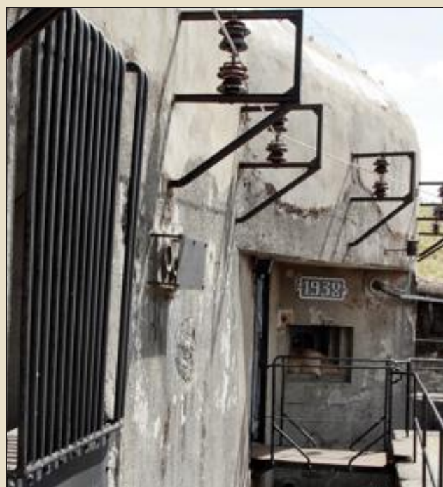
Le fort Casso, situé sur les hauteurs de Rohrbach-lès-Bitche. Photo Thierry NICOLAS
