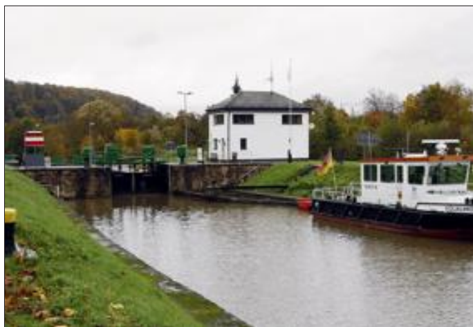
L'écluse de Gündingen est la première écluse allemande entre Sarreguemines et Sarrebruck, sur le canal de la Sarre.
