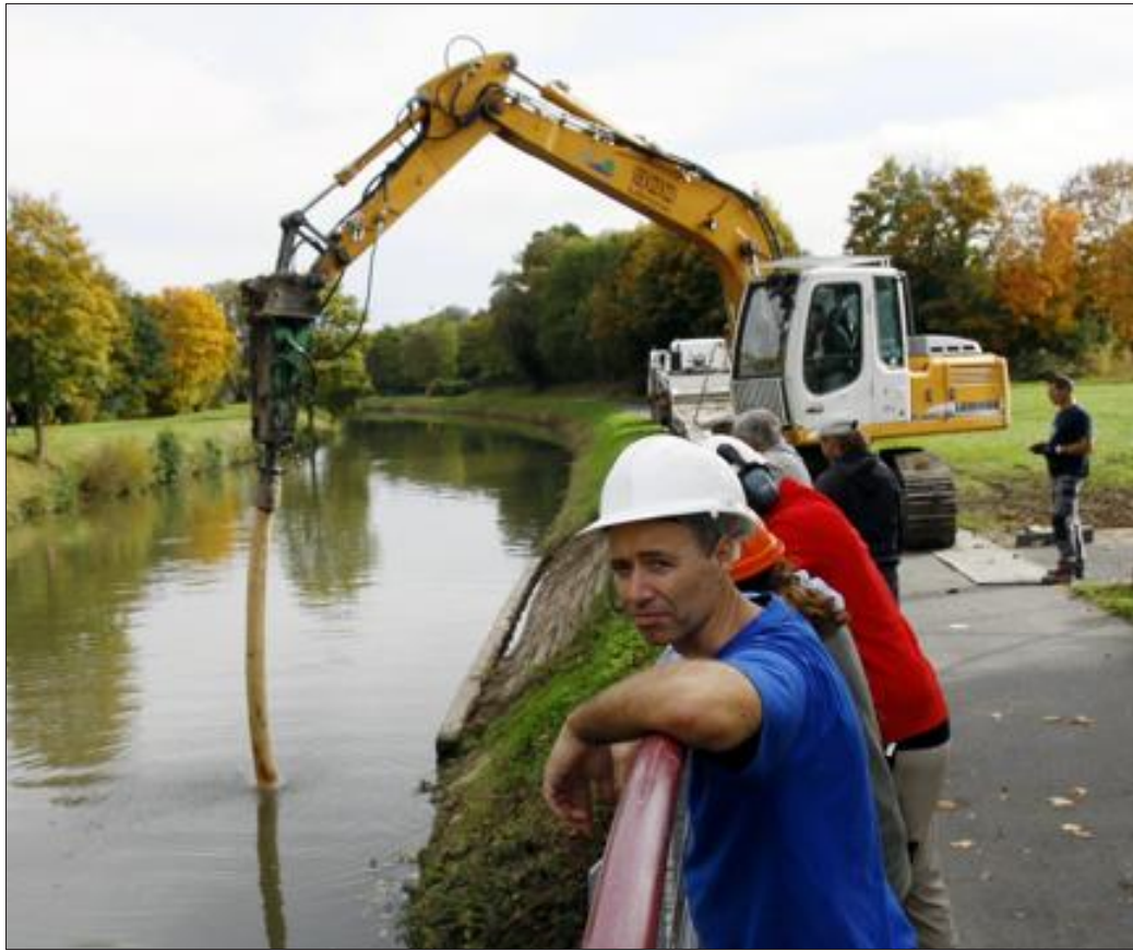
Les pieux qui soutiendront l'embarcadère ont été installés. On pourra ainsi faire une halte fluviale à Grosblierstroff. A condition que l'écluse de Güdingen ne soit pas fermée... Photo Thierry NICOLAS.
