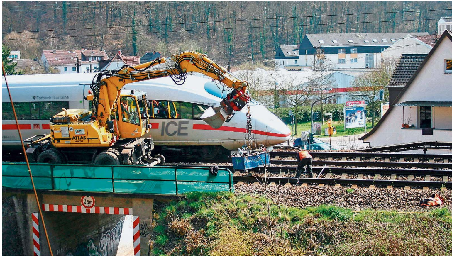
Zwischen Schafbrücke und Scheidt repariert die Deutsche Bahn AG die Gleise. FOTO: HEIKO LEHMANN
