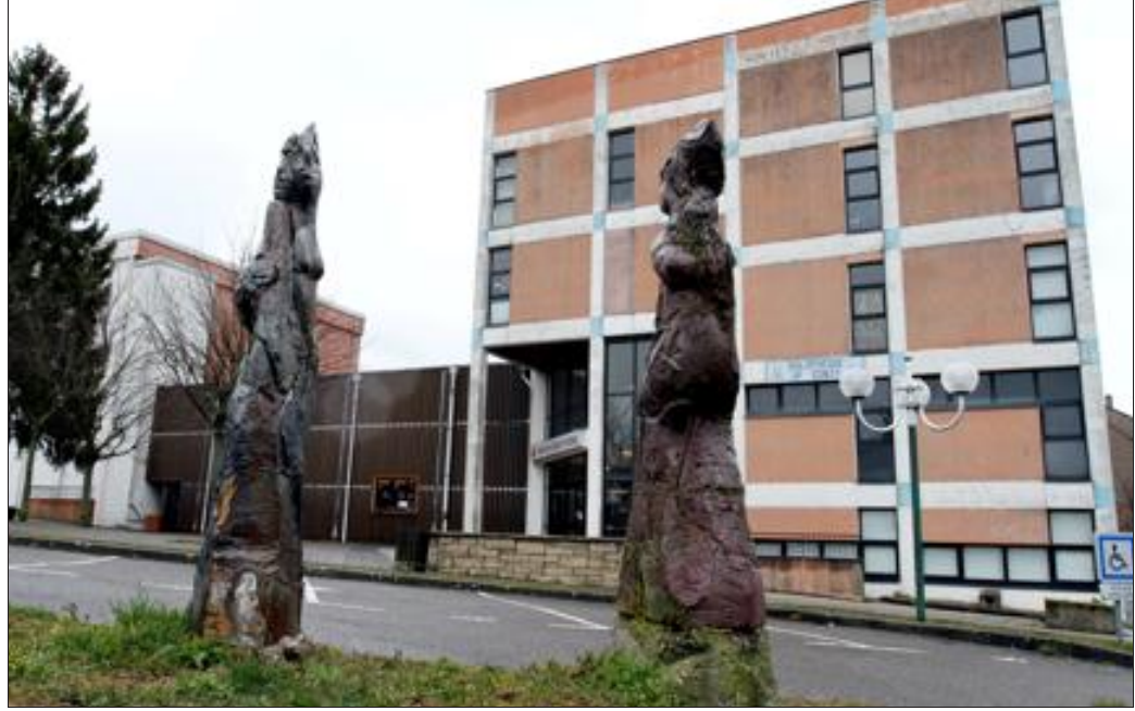
La MCF doit devenir médiathèque. Un projet soutenu par l'Eurodistrict. Photo RL
