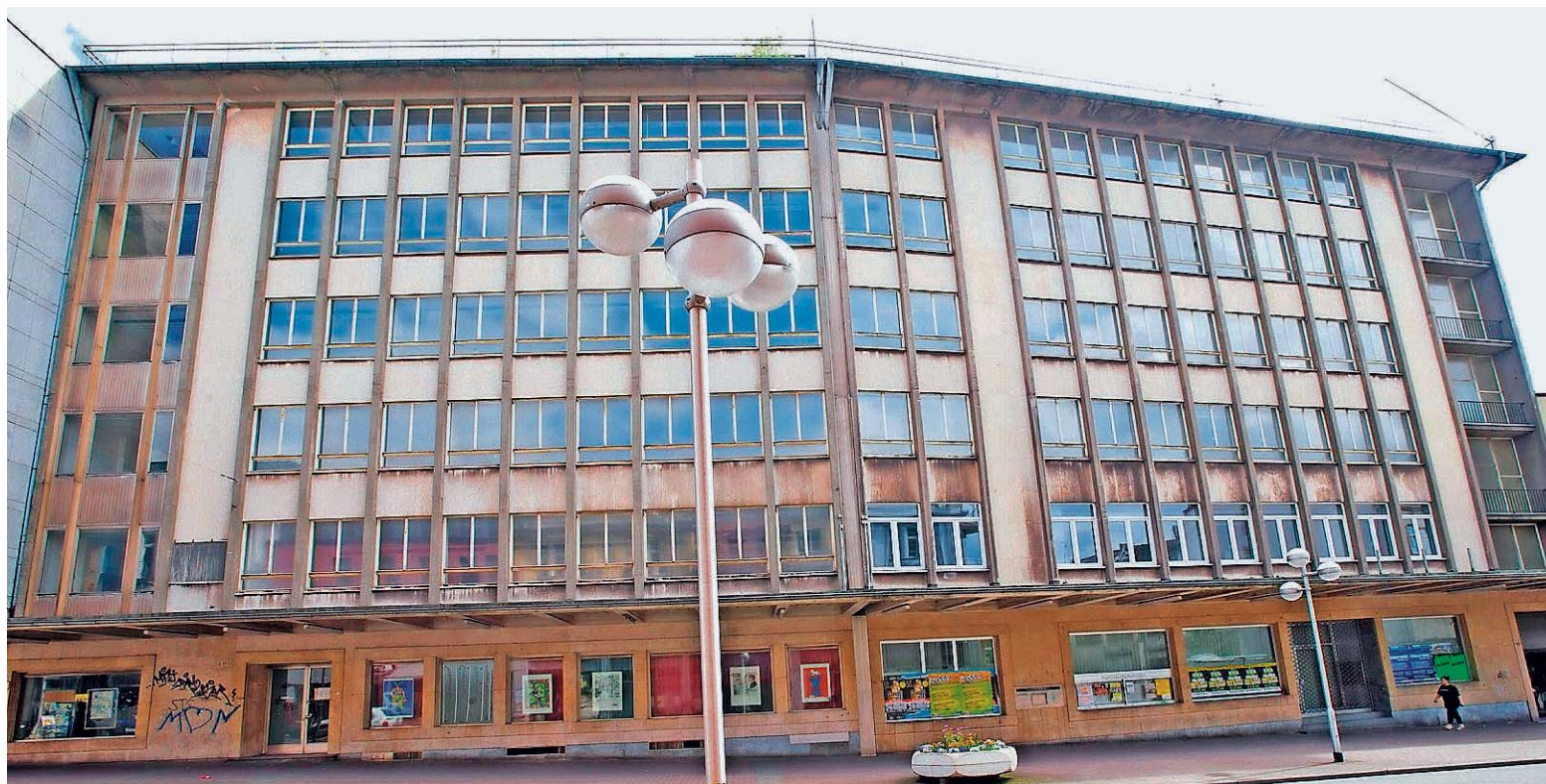
Diese Bauten, seit Jahren leer, sollen künftig der Stadtverwaltung dienen. Rechts die ehemalige Röchlingbank, Rathausstraße 33, nach wie vor Saarstahl-Eigentum. Links – Hausnummer 29-31 – das frühere Saarstahl-Casino; die Ostermann-Gruppe, der der Bau gehört, ist nach Auskunft von Völklingens Rathauschef Klaus Lorig jetzt bereit zum Verkauf. ARCHIVFOTO: JENAL
