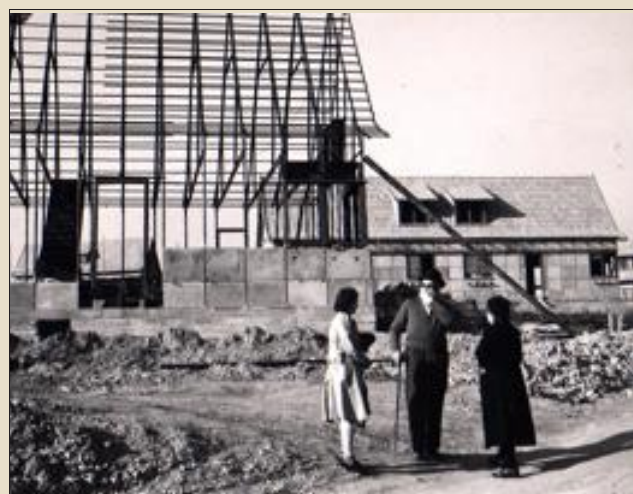
Le plein-emploi est aussi synonyme de nouvelle construction comme ici à la cité des Chênes (vers 1950).
