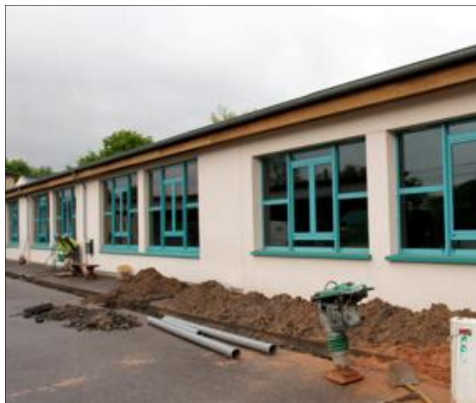
L'école Riviera est en cours de reconstruction. Photo Ph. R.
