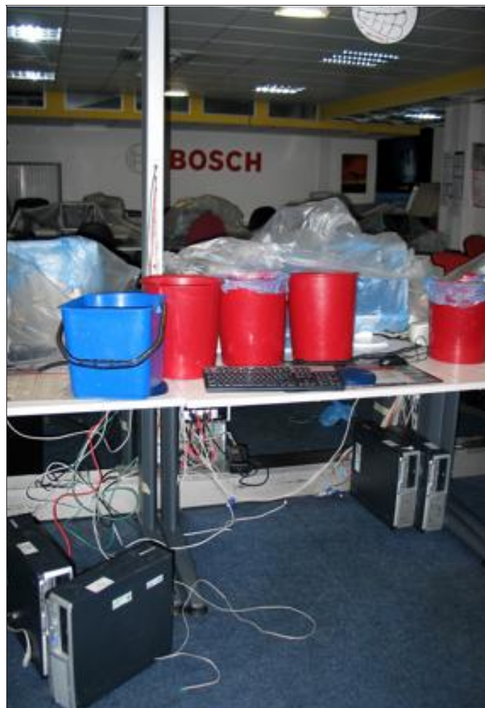
Les postes informatiques ont rapidement été mis à l'abri pour les protéger de l'eau qui s'est rapidement écoulée du plafond. Photo R. L.
