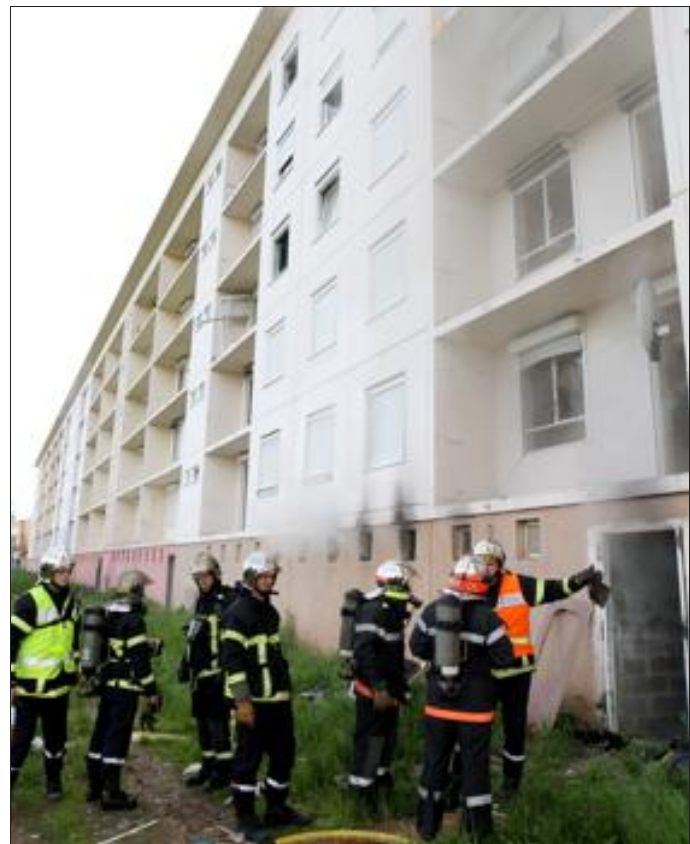
Heureusement le feu a pris dans un bâtiment désaffecté voué à la démolition. Photo Philippe RIEDINGER
