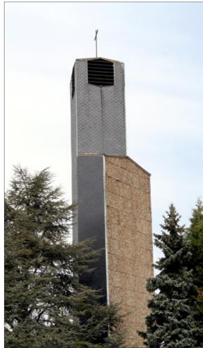
Outre le clocher de l'église, la mairie, l'école, le cimetière, la résidence des Mélézes, le bloc des Douanes, le presbytère, des logements rue Nationale, ainsi que le réseau d'assainissement sont concernés.
